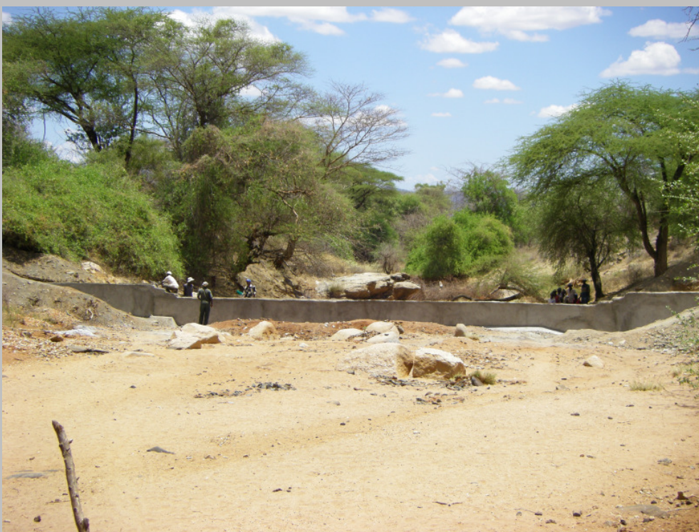
Dieser Damm in Kenia (Region Mwingi) führt in der Regenzeit zur Anhebung des Grundwasserspiegels. In der nächsten Trockenzeit werden die Trinkwasserbrunnen nicht mehr versiegen. (Foto: Schneider/Welthungerhilfe)
