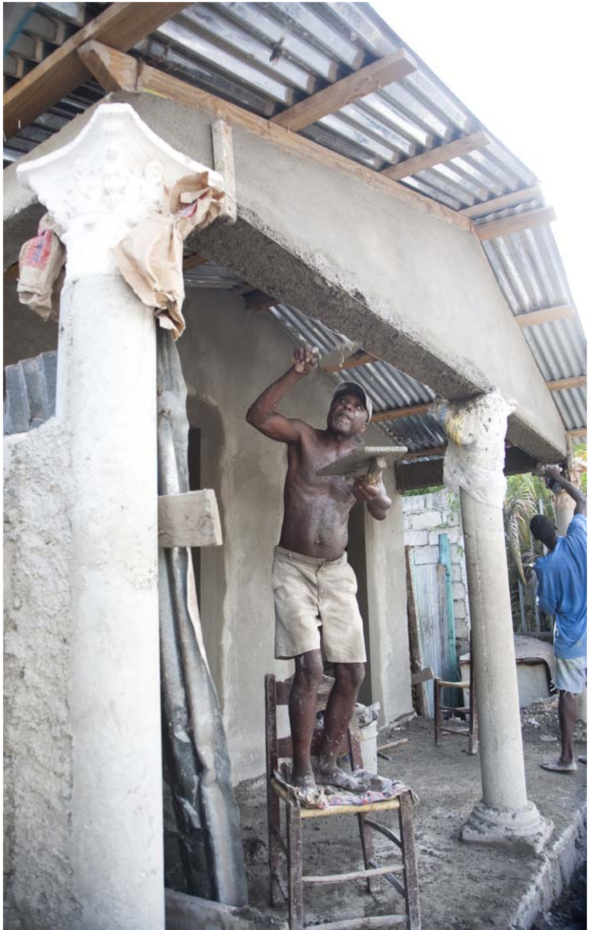
Auferstanden aus Ruinen: Die Vision für Haiti ist ein kompletter Neuaufbau des Landes. Das Motto lautet „Building back better“. Foto: Mueller/Welthungerhilfe
