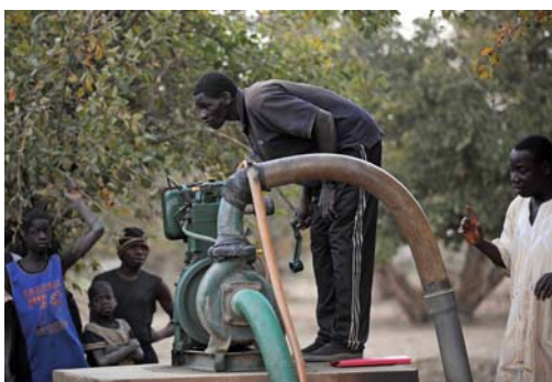
Pumpstation zur Bewässerung der Gemüseärten in Tangaye
