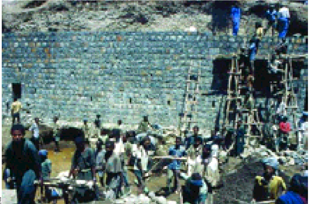
Massive Mauern werden errichtet, um die Macht der Regenfluten zu brechen und die Berghänge vor Erosion zu schützen.
