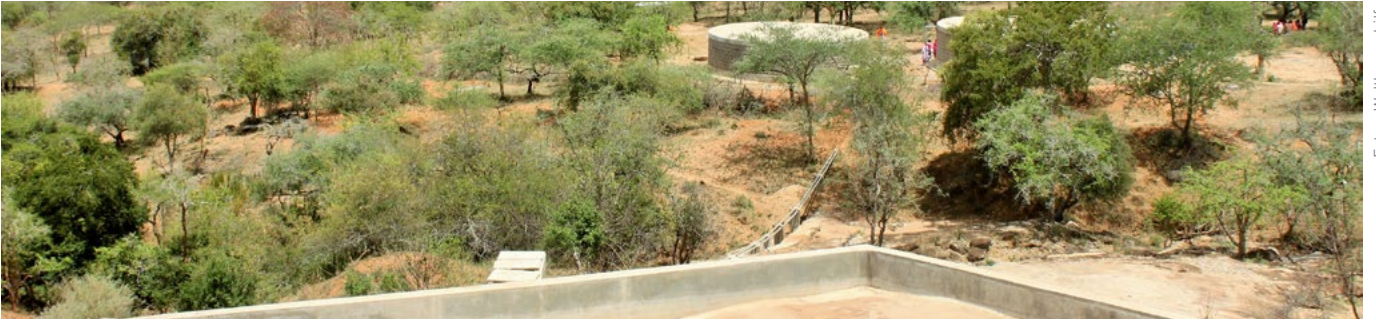
MDG 7: Felsregenfang für verbessertes Trinkwasser
